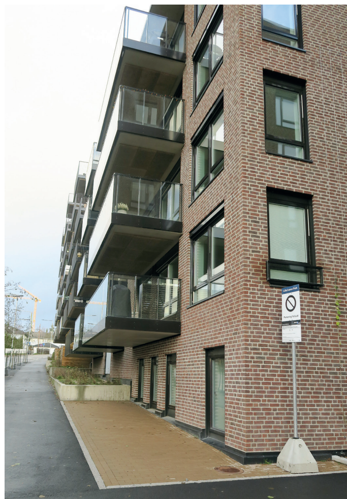
Det er brukt teglsteinfasader i prosjektet.
